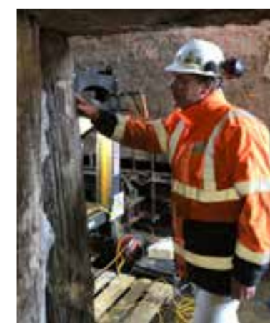
Visuele inspectie blootgegraven funderingspaal
