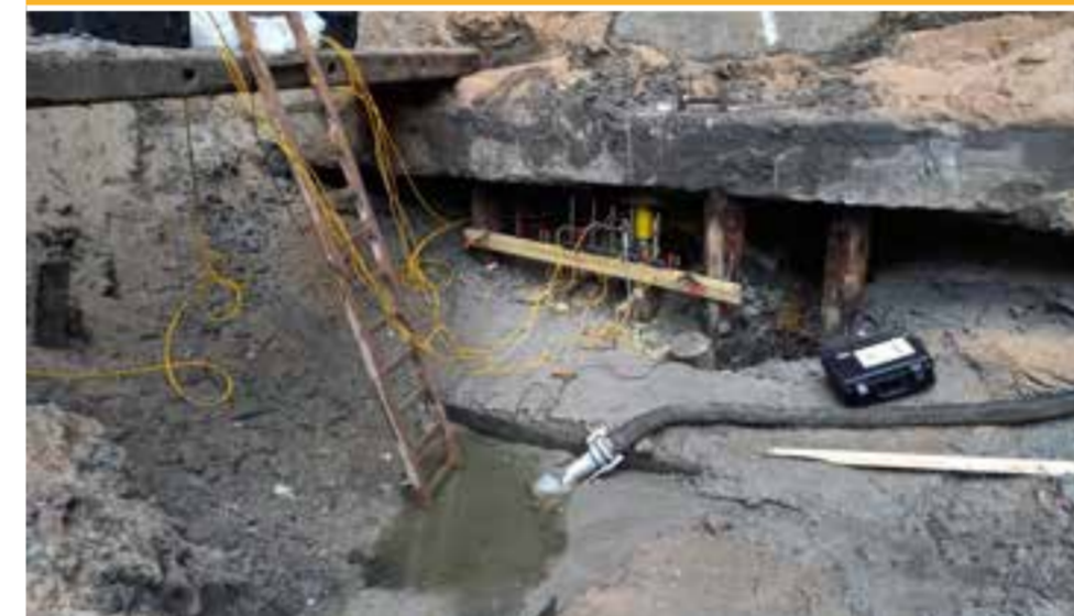
Overzicht proefbelasting paal onder bestaand gebouw
