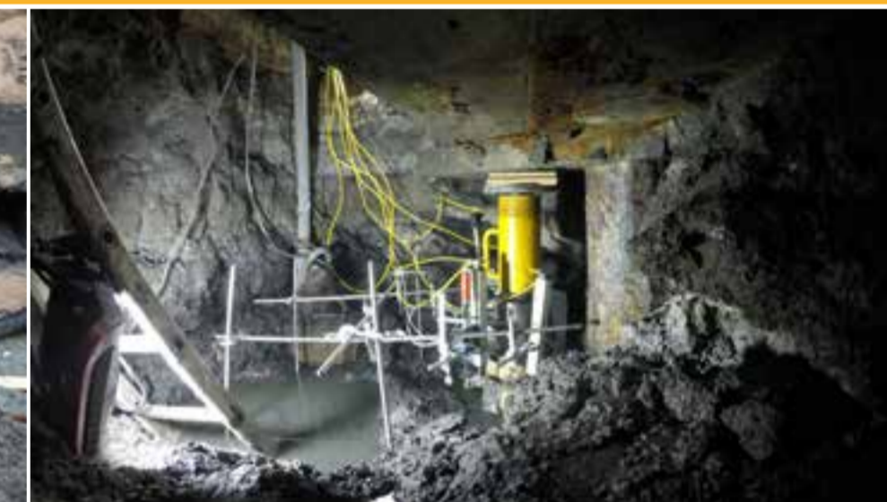
Detail proefbelasting paal onder bestaand gebouw
