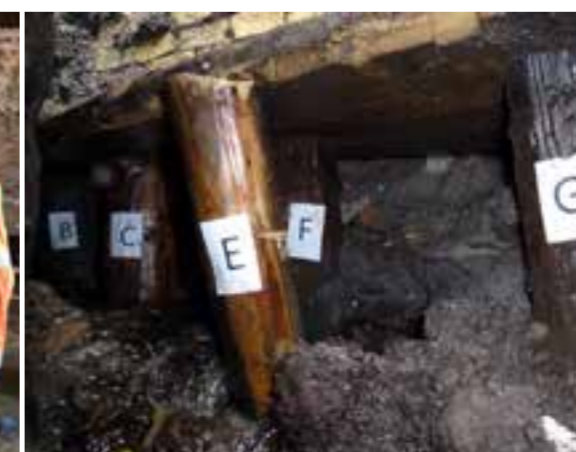
Blootgegraven funderingspalen onder bestaand pand, Klaar voor inspectie
