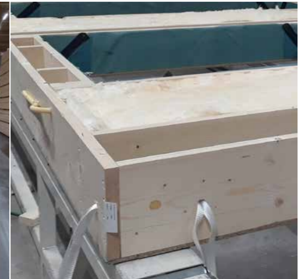
Productie van gevelement
